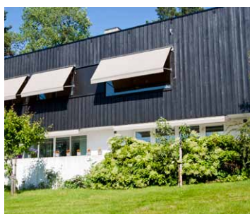
Vindusmarkiser med sol- og vindautomatikk.
