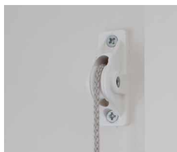
Snoren føres inn i veggen gjennom en trinse
