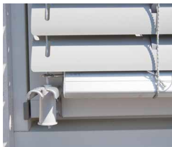
Styrewire festes til en spennvinkel.
