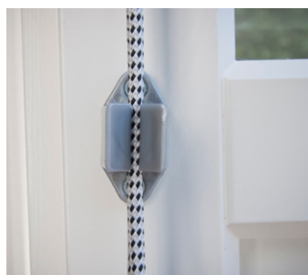
Feste for runddragssnor på innvendig karm.
