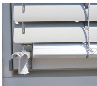
Styrewire festes til en spennvinkel.
